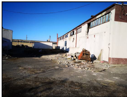
Widok na utwardzenia wokół budynków z płyt betonowych, płyt chodnikowych i masy bitumicznej
