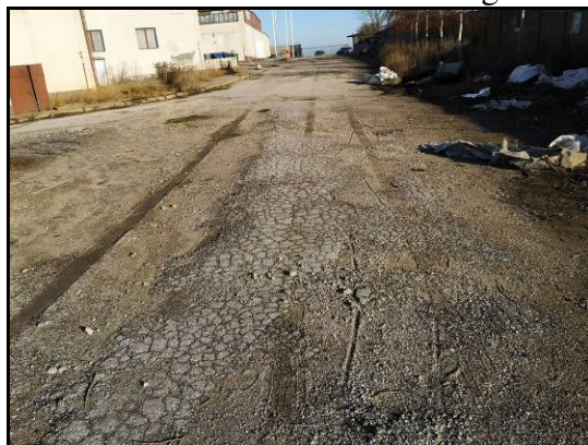
Widok na utwardzenia wokół budynków z płyt betonowych, płyt chodnikowych i masy bitumicznej
