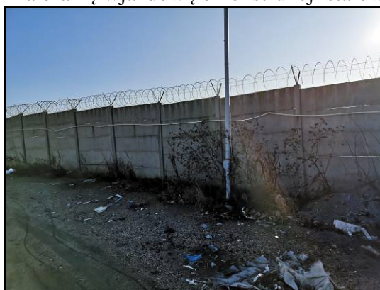
Widok na ogrodzenie z płyt betonowych
