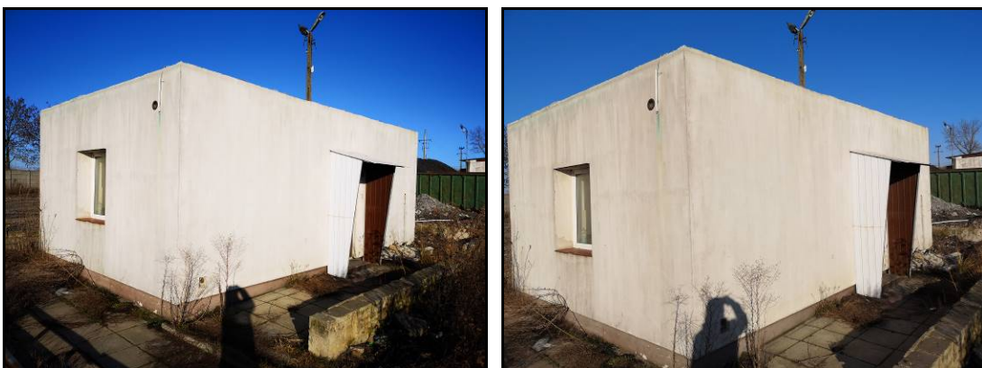
Widok ogólny na budynek wagi
