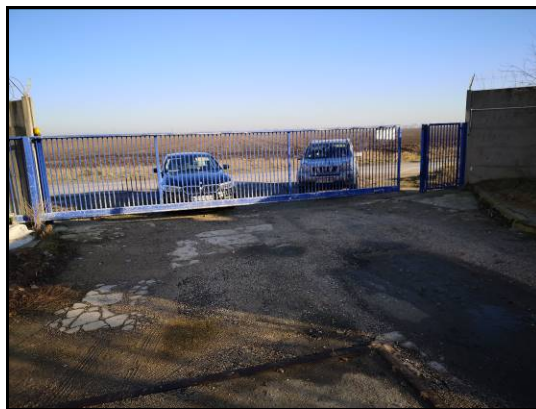
Widok na ogrodzenie z płyt betonowych oraz na bramę wjazdową o konstrukcji stalowej
