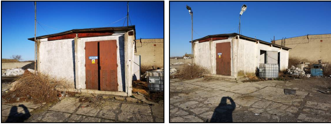
Widok ogólny na budynek trafostacji
