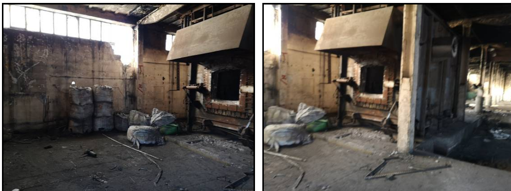
Widok wewnątrz budynku – hala sortowni – piec
