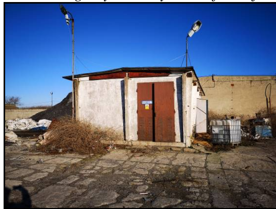
Widok ogólny na budynek trafostacji
