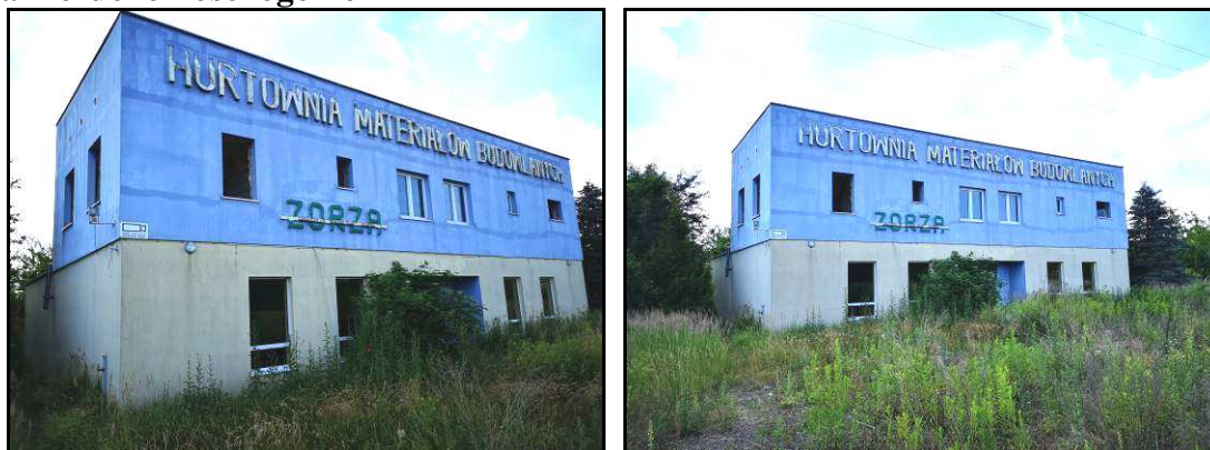
Widok ogólny na budynek biurowo – usługowy
