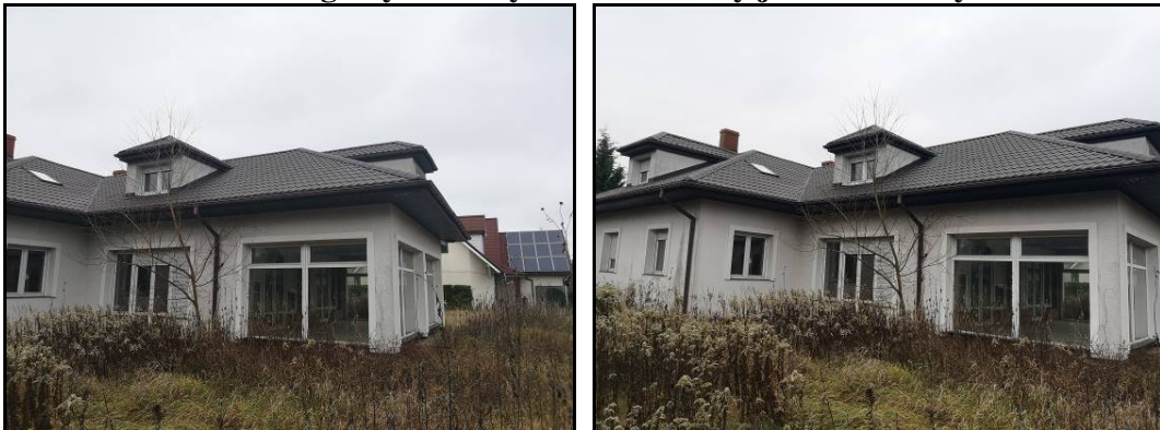
Widok ogólny na budynek mieszkalny jednorodzinny
