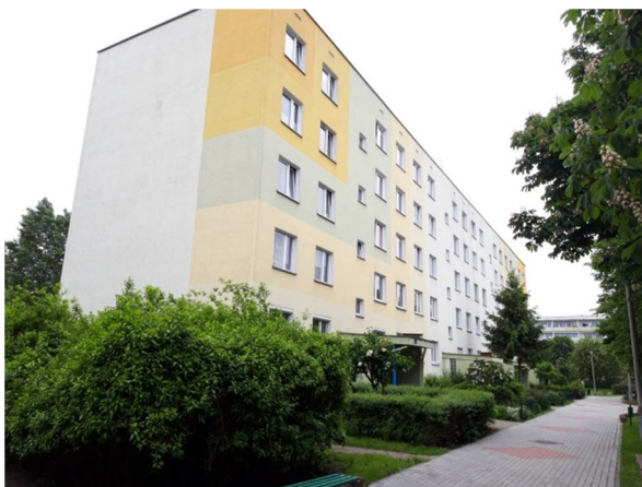
elewacje południowa i wschodnia budynku
