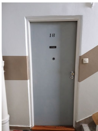
drzwi wejściowe do lokalu
