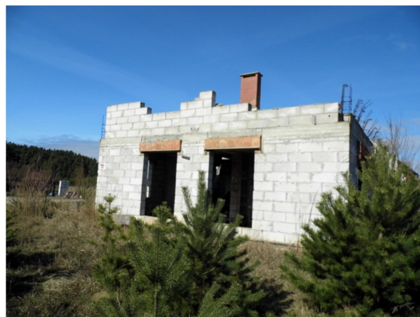
widok na budynek od południa
