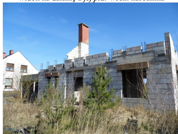
widok na budynek od zachodu
