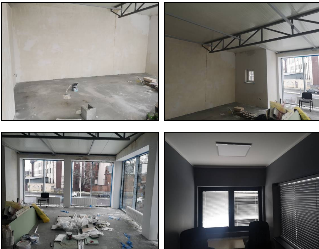
Widok wewnątrz budynku – biuro – piętro
