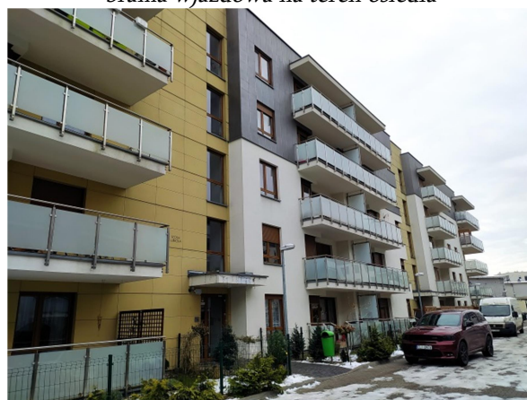
elewacja zachodnia budynku
