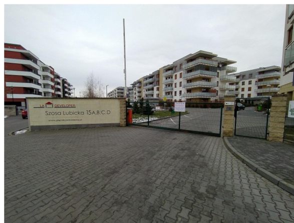
brama wjazdowa na teren osiedla
