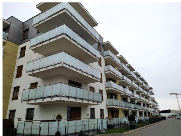
elewacja wschodnia budynku
