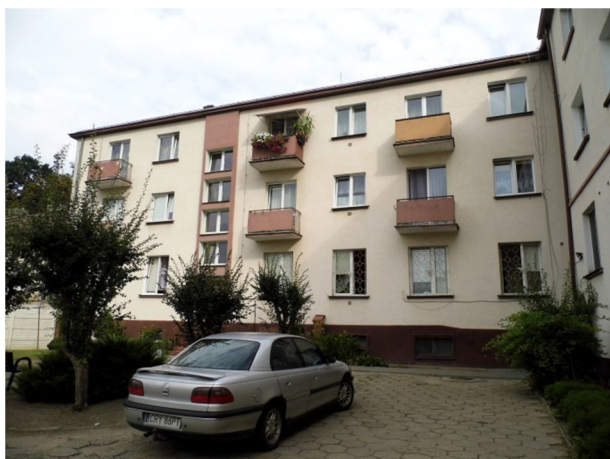
elewacja południowa budynku – widok od strony podwórka
