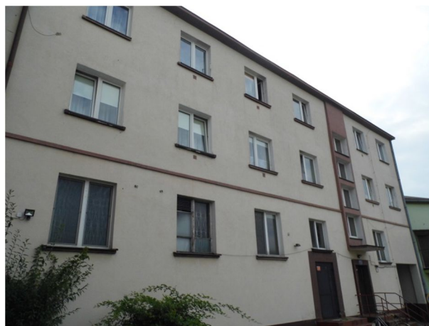
elewacja zachodnia budynku – widok od strony podwórka
