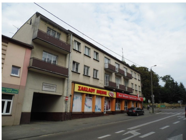
elewacja wschodnia budynku – widok od ulicy Kościuszki
