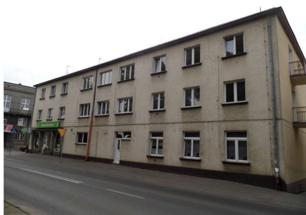
elewacja północna budynku – widok od ulicy Lipnowskiej
