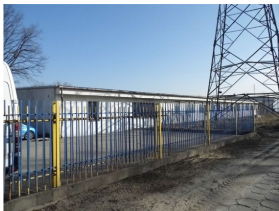
ogrodzenie nieruchomości od strony południowej posadowione na działce drogowej nr 32/1
