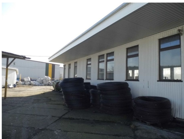
północno-wschodnia część budynku – hala produkcyjna
