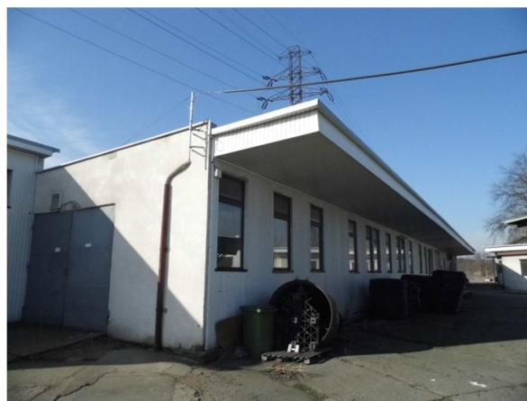
północno-wschodnia część budynku – hala produkcyjna
