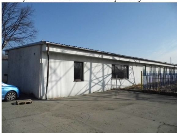
południowo-zachodnia część budynku – część biurowa
