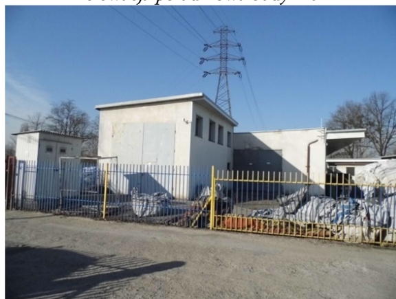
elewacja wschodnia budynku
