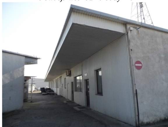
północno-zachodnia część budynku – część biurowa
