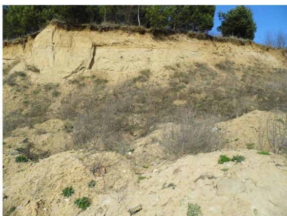
północna część działki stanowiąca skarpe
