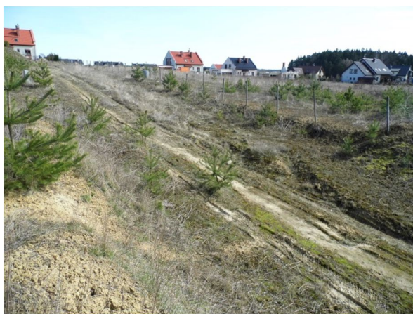
nieurządzona droga gruntowa po stronie południowej
