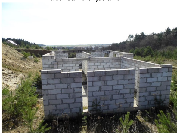
widok na budowę od strony północnej
