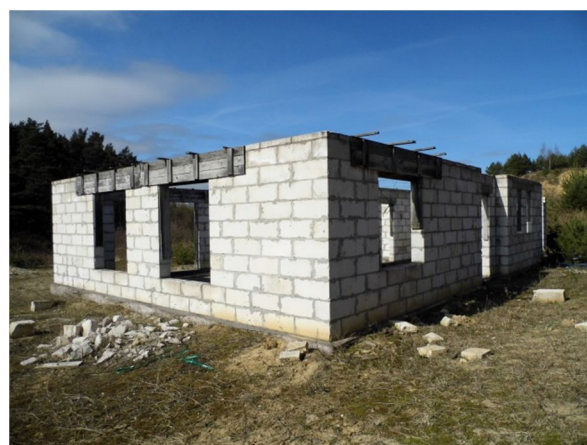
widok na budowę od strony płd.-wsch.
