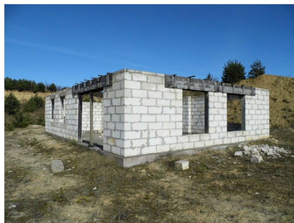
widok na budowę od strony płd.-zach.
