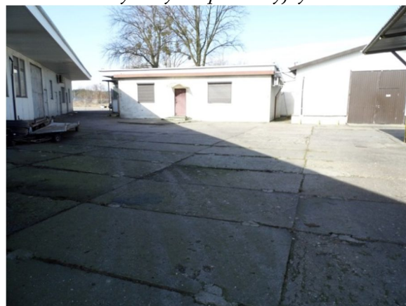
centralna część – widoczny budynek biurowy nr 150
