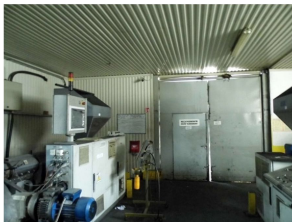
wschodnia część budynku
