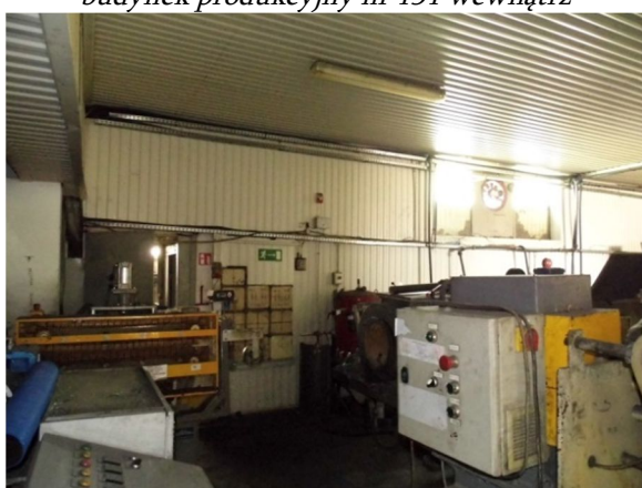
północno-zachodnia część budynku
