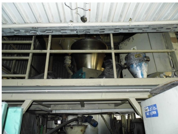
platforma wewnątrz budynku
