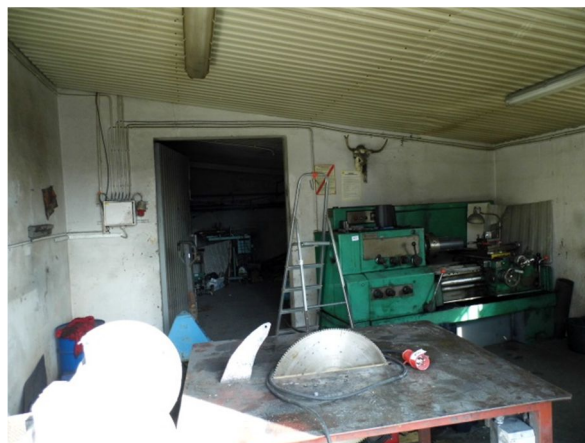
budynek magazynowy nr 149 wewnątrz
