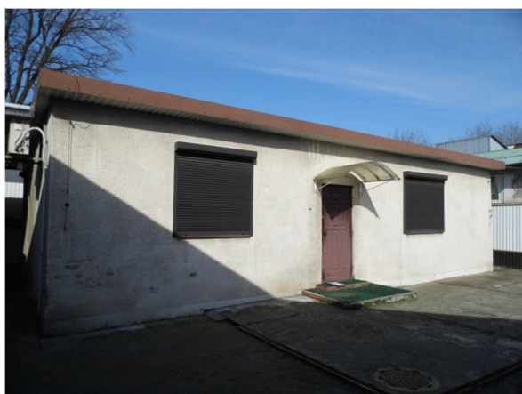
elewacja wschodnia budynku
