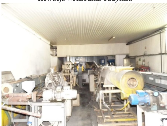
budynek produkcyjny nr 151 wewnątrz
