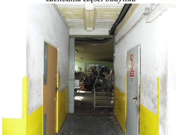
południowo-zachodnia część budynku – widoczne przejście do budynku nr 153
