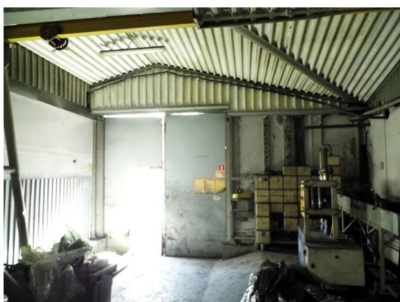
wschodnia część budynku
