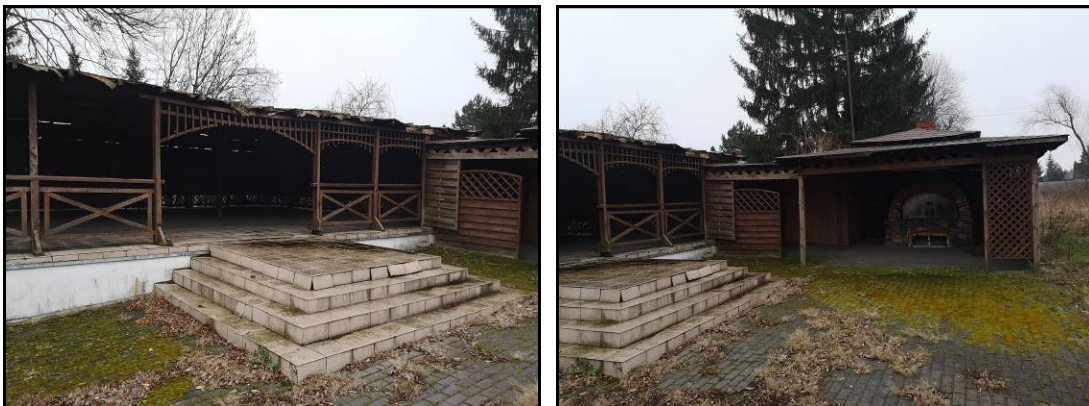
Widok ogólny na budynek magazynowy
