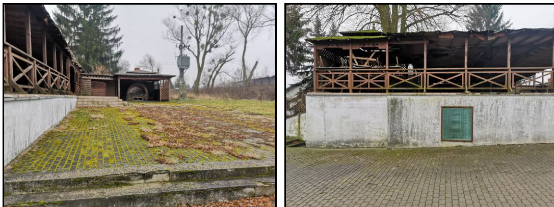
Widok ogólny na budynek magazynowy
