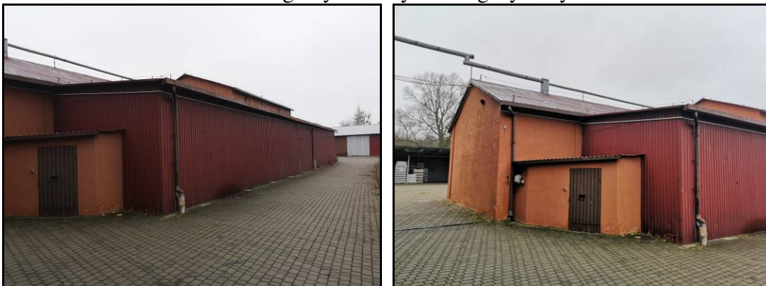
Widok ogólny na budynek magazynowy
