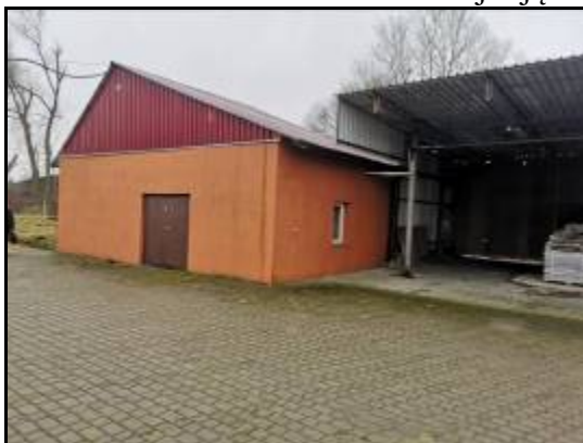
Widok na utwardzenia podłoża w postaci kostki brukowej typu polbruk
