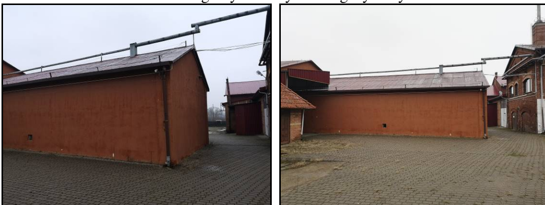
Widok ogólny na budynek magazynowy
