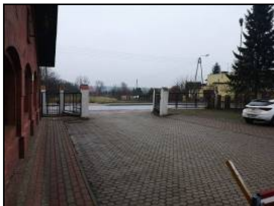
Widok na bramę wjazdową na teren nieruchomości – ogrodzenie z siatki stalowej na słupach murowanych
