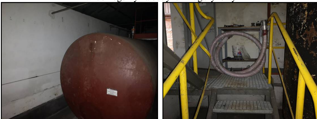
Widok wewnątrz budynku magazynowego
