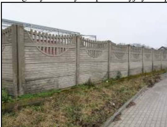
Widok na ogrodzenie z elementów betonowych oraz z siatki stalowej na słupkach stalowych
