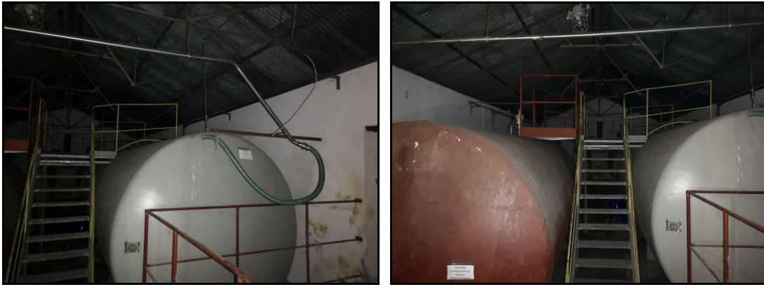
Widok wewnątrz budynku magazynowego
