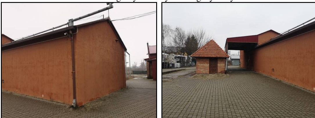
Widok ogólny na budynek magazynowy
