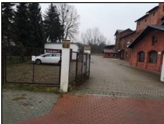
Widok na bramę wjazdową na teren nieruchomości – ogrodzenie z siatki stalowej na słupach murowanych
