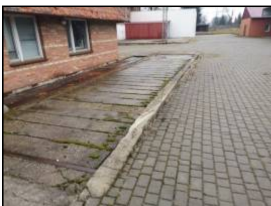
Widok na utwardzenia podłoża w postaci kostki brukowej typu polbruk
