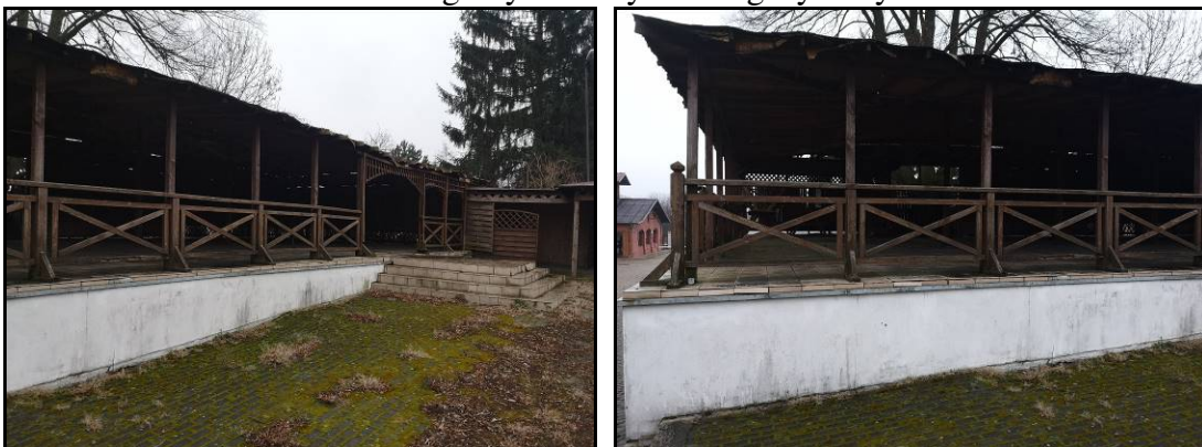
Widok ogólny na budynek magazynowy
