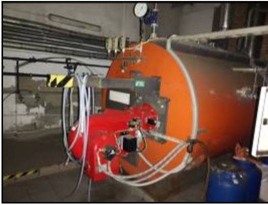
Widok na piec grzewczy na olej opałowy
