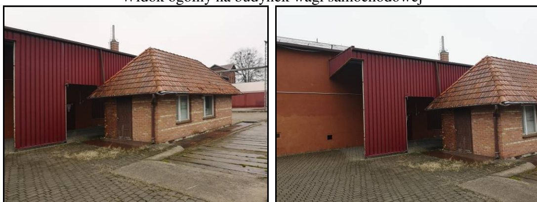
Widok ogólny na budynek wagi samochodowej
