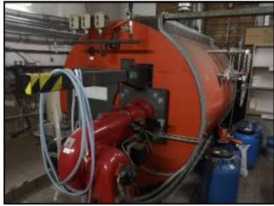
Widok na piec grzewczy na olej opałowy
