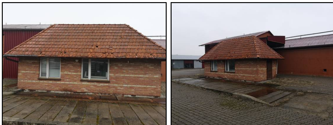
Widok ogólny na budynek wagi samochodowej
