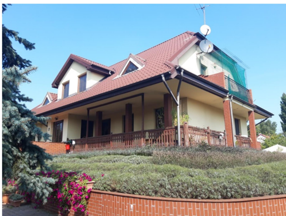
elewacje zachodnia i południowa budynku
