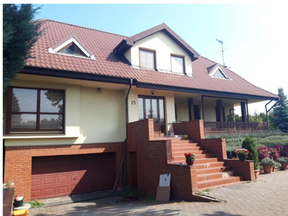
elewacja zachodnia budynku
