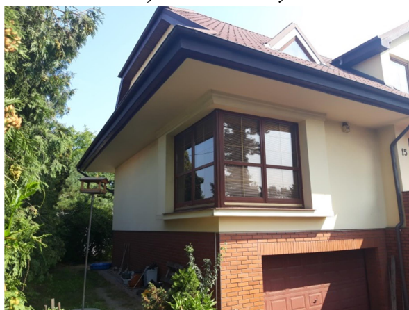
elewacja północna budynku
