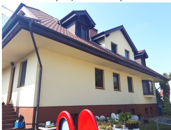
elewacja wschodnia budynku
