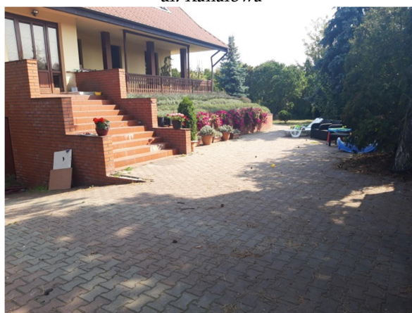
obszar po stronie zachodniej budynku
