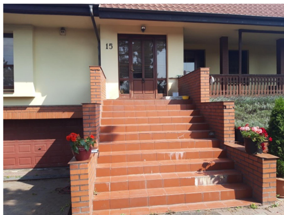
schody wejściowe do budynku
